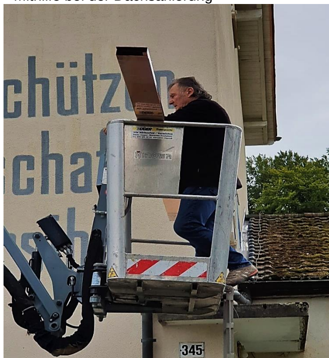
Markus im Element und bei der tatkräftigen Mithilfe bei der Dachsanierung
